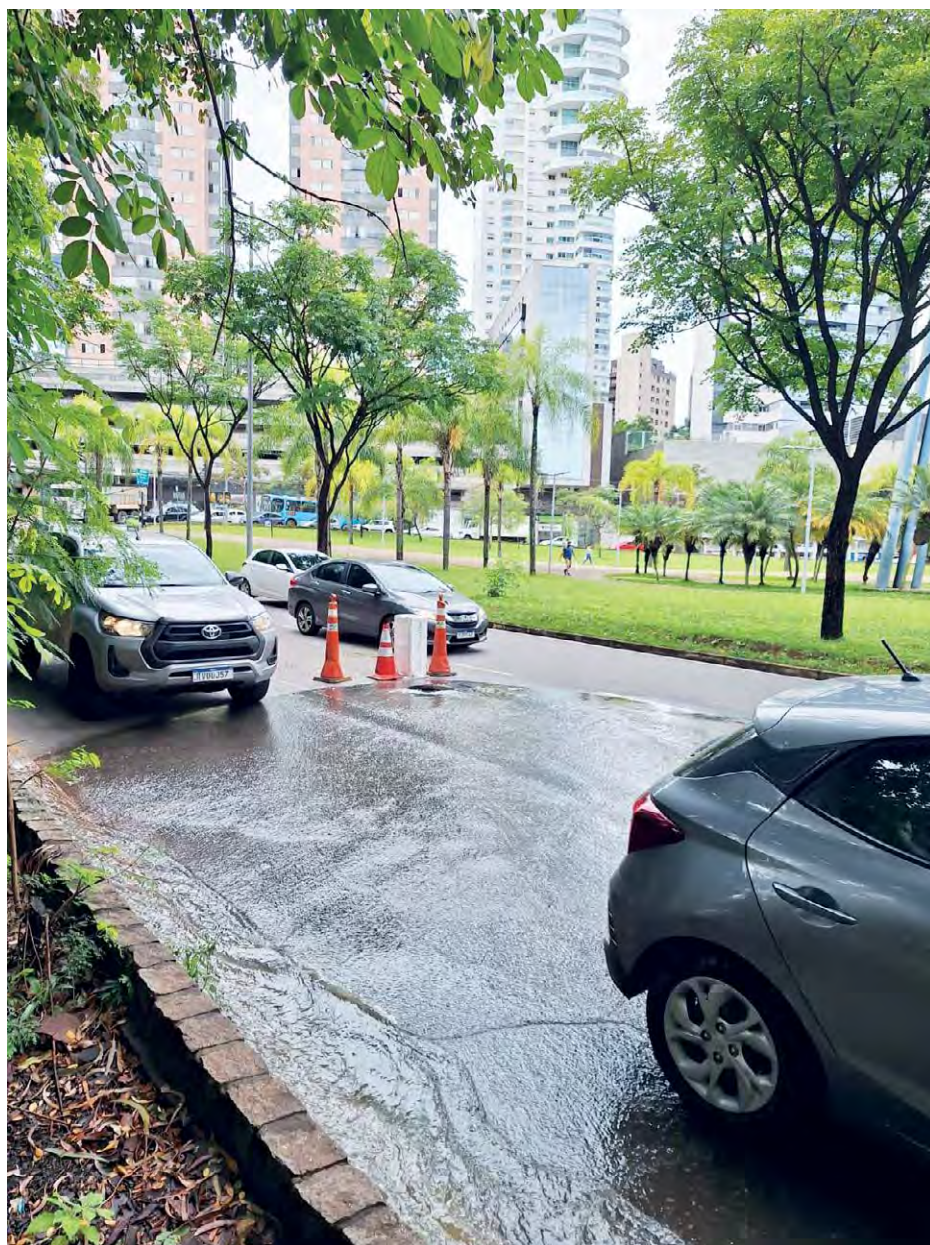
Belvedere: O extravasamento de esgoto acontece de forma generalizada e a cada dia um novo ponto surge com esgoto a céu aberto nas ruas do bairro
