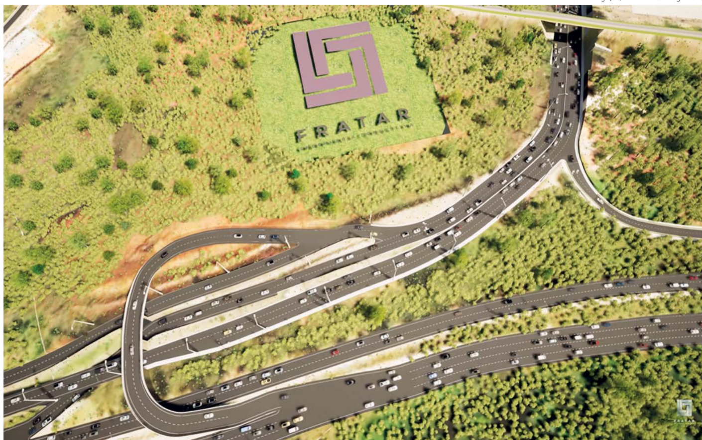
© Foto: Divulgação/Cedida Fratar Engenharia
