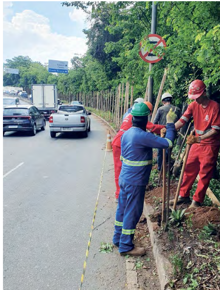
Lagoa Seca: Operários iniciaram o fechamento da área para a construção da terceira via da pista de acesso a MGS-356, no Belvedere
