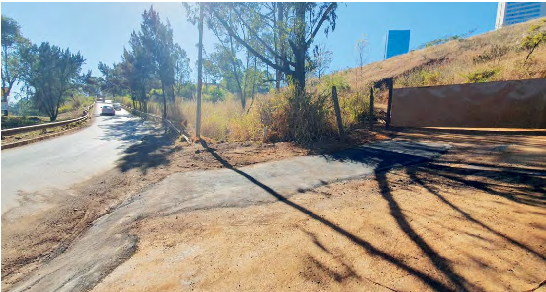
Ao lado da Alcinha: O acesso ao garimpo é feito pela curva da alcinha, onde foi retirada parte do guard-rail para acesso a caminhões e colocada uma fina camada de asfalto
