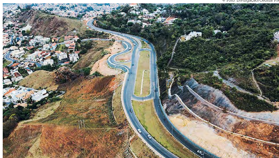
Avenida Dr. Flávio Guimarães: Os serviços de pavimentação, drenagem superficial e contenções estão ainda mais avançados
