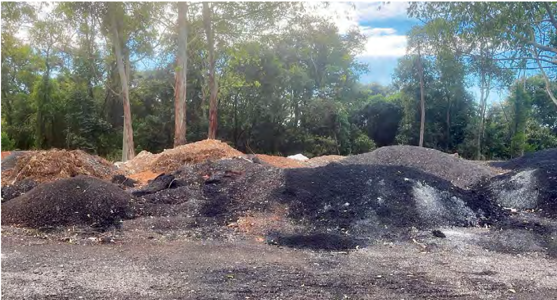
Perigo: O depósito de grandes pilhas de material fresado de pavimento asfáltico (RAP), realizado pela concessionária EPR Via Mineira às margens da BR-040, na área de amortecimento da Estação Ecológica
