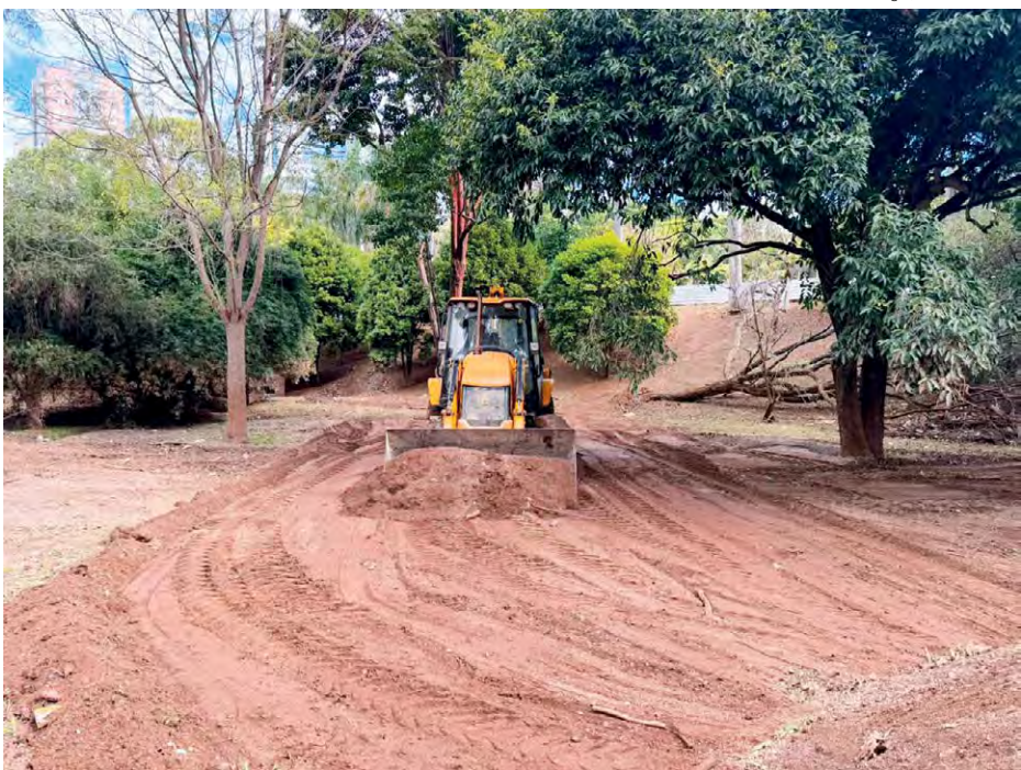
Belvedere: Lagoa Seca: A máquina abriu valas, encheu as caçambas de caminhões, moveu terra, nivelou parte do solo e retirou restos de galhos de árvores mortas, detritos e muito lixo
