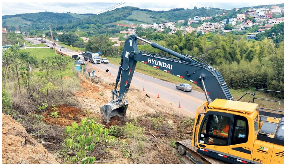
BR-040: Em Congonhas, as equipes de trabalho atuam em frentes de terraplenagem e limpeza mecanizada
